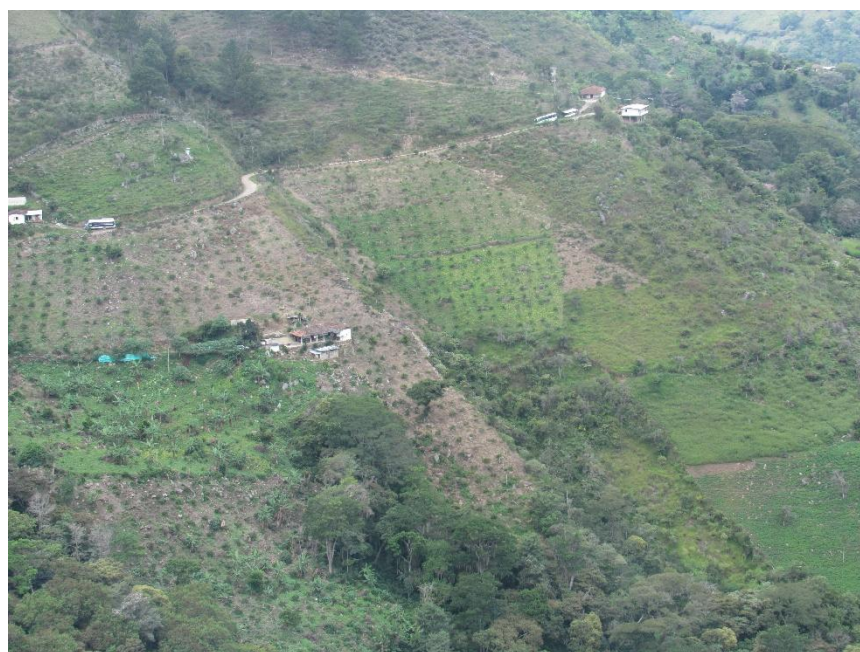
Terrenos con algo grado de vulnerabilidad a fenómenos como deslizamientos y remoción en masa.
