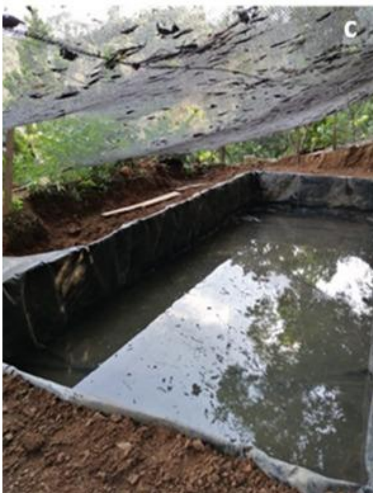
Imagen de JAIRO ROJAS Construcción de puntos de captación de agua.
